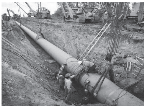
写真2 X100 グレードラインパイプの敷設状況
