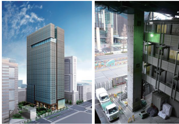
(a) 完成予想図 (b) 施工中の超高強度 BOX 柱
